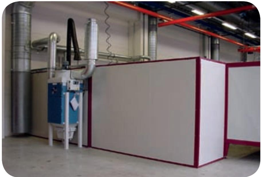
Die Lärmschutzwände bestehen aus vorgefertigten Elementen, die formschlüssig verbunden werden. Die offenen Ober- und Unterkanten werden mit einem Blechprofil abgedeckt. Das Element selbst besteht aus laminiert angeordneter Steinwolle mit einem Raumgewicht von 170 kg/m<sup>3</sup>, welche mit Blech oder Lochblech von 0,6 mm Stärke abgedeckt wird.
