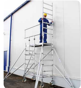
Gesichert durch das „vorlaufende“ Geländer kann die Plattform nun gefahrlos betreten und der weitere Gerüstaufbau fortgesetzt werden. Das Montagesicherungsgeländer wird für folgende Plattformen wieder „vorlaufend“ eingesteckt ehe die nächste Ebene betreten wird.
