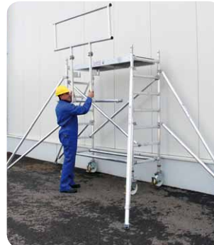
Vor dem Besteigen der ersten Plattform wird der Zusatzrahmen mühelos vom Boden aus eingesteckt.
